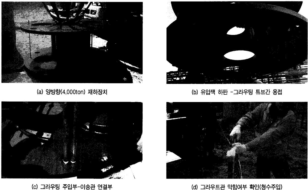
그림 8. 포스트그라우팅 장치 및 양방향 재하장치 설치 전경
