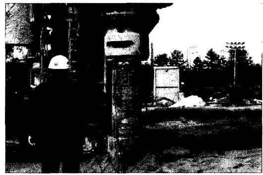
(b) 말뚝 설치
